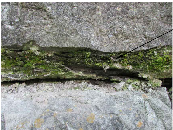
4 HEAVY DELAMINATION SSK-6 SCALE: N.T.S.
